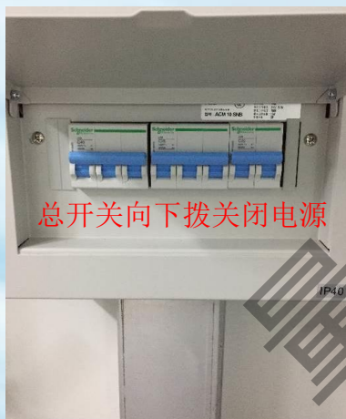
图1 电源总开关
