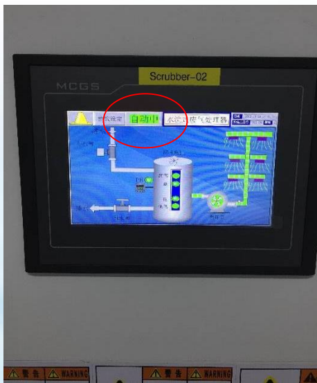
图1 尾气处理开启状态 “自动中”表示开启
